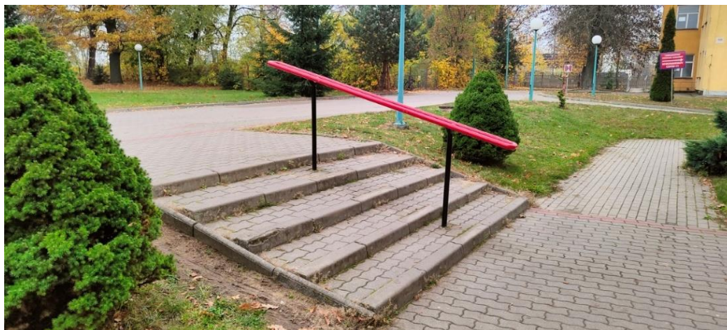
Zdjęcie nr 2: Schody zewnętrzne w strefie dojścia do placówki.
