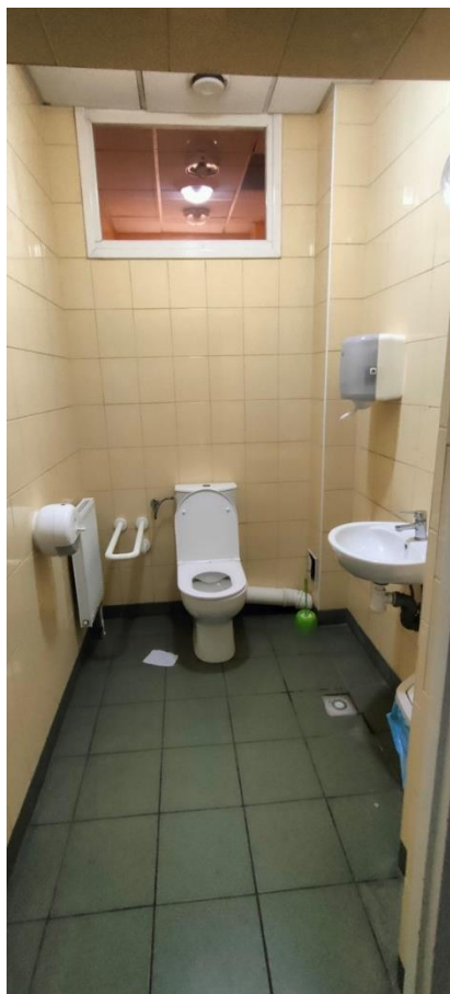
Zdjęcie nr 6: Toaleta przy wejściu głównym do placówki.
